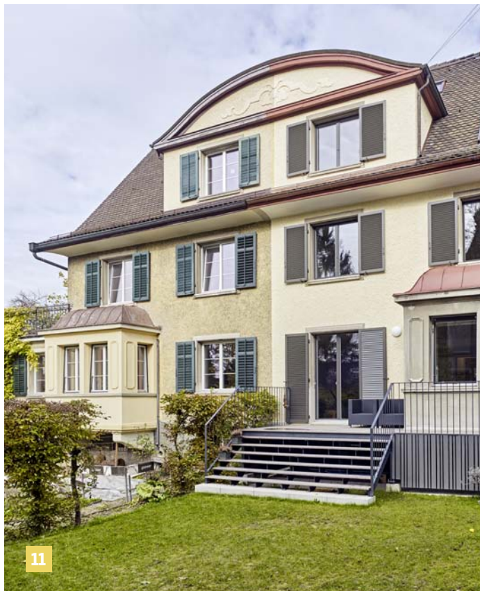
11 Deutlich sind die Neuerungen am rechten Hausteil des Doppelfamilienhauses zu erkennen. Das Dach wurde stellenweise geflickt, die Fenster und die Fassade erneuert und eine neue Terrasse schafft mehr Aussenraum.
